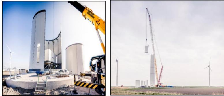
Figure 8 : Installation d'une tour acier modulaire
